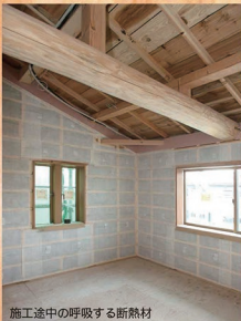
施工途中の呼吸する断熱材
