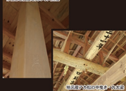
構造耐力が通常の2倍の丸太工法
