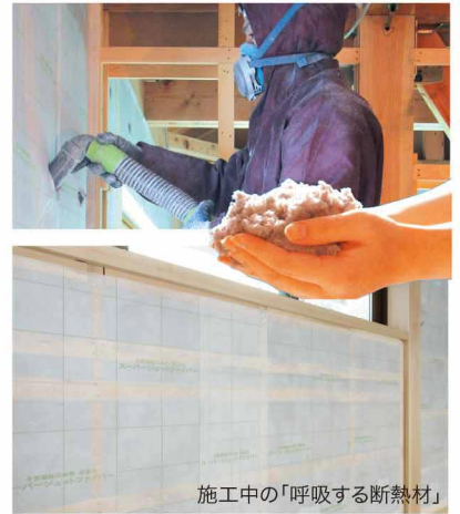
施工中の「呼吸する断熱材」
