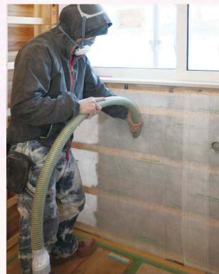
壁の中いっぱいに隙間なく入り、一般的な断熱材の約3倍の高密度。
