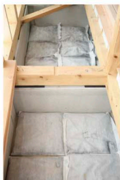
■木炭：床下の結露やカビを防止。最適な湿度に保ちます。長期的視点から耐震装置と言えるでしょう。
