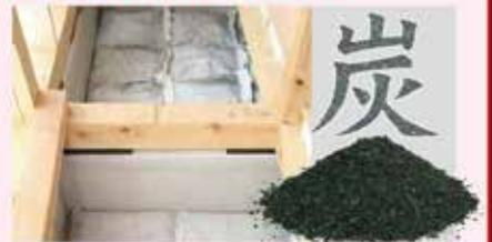
室内との温度差により床下では結露が発生します。木炭を敷き詰めると呼吸を繰り返し、一定の湿度になるように吸放湿して結露しません。地震や腐食から住まいを守ってくれます。
