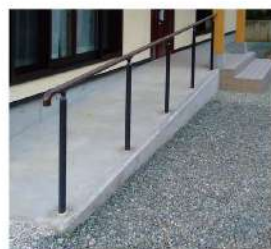
■スロープを設置
