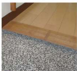
■床の段差を できる限りなくす
