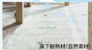
床下断熱材(自然素材)
