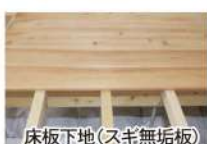
床板下地(スギ無垢板)
